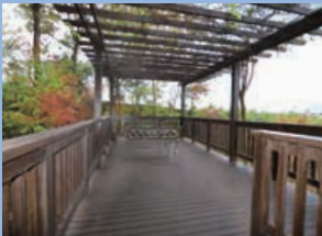
ウッドテラス
